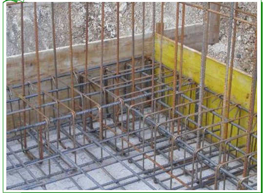
armatura trave spigolo est corpo B by Rossi ing. Antonio (DL)
